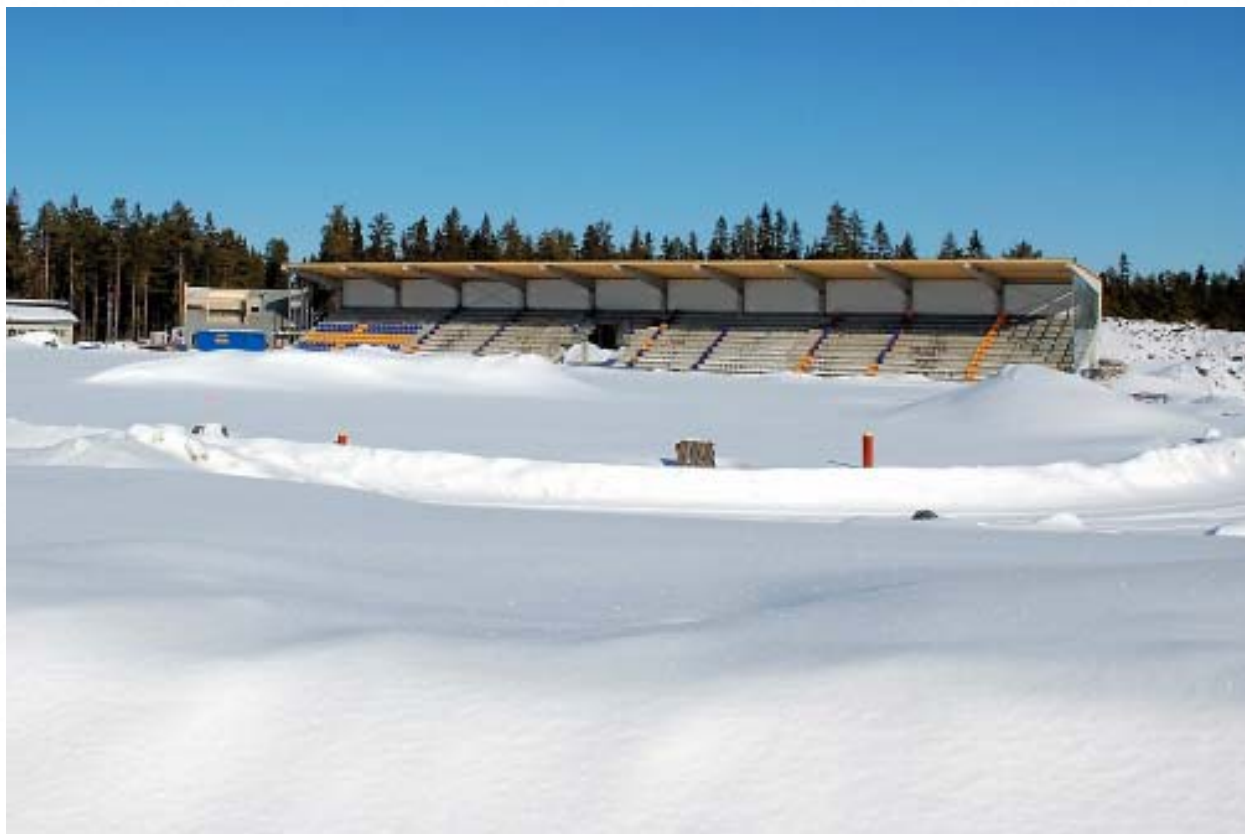
Byggandet av Campus Arena pågick mitt i smällkalla vintern. Foto: Thomas Björklund
